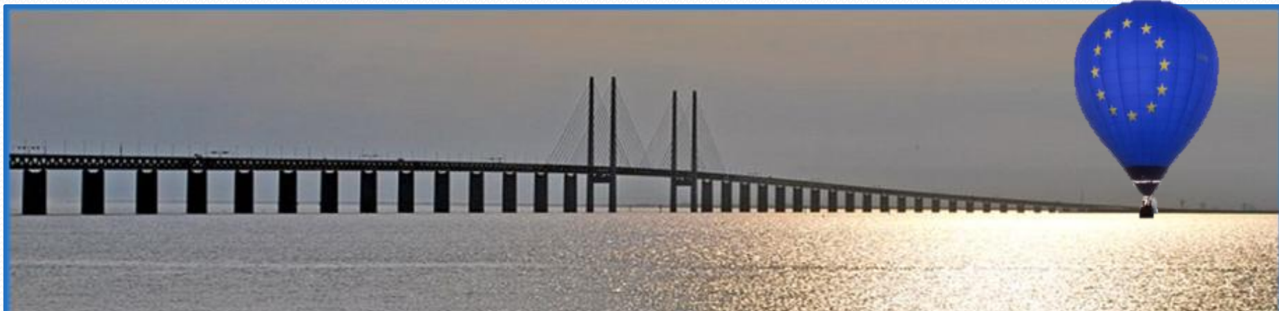
Il ponte di Øresund, completato nel 1999, collega la Svezia e la Danimarca.
